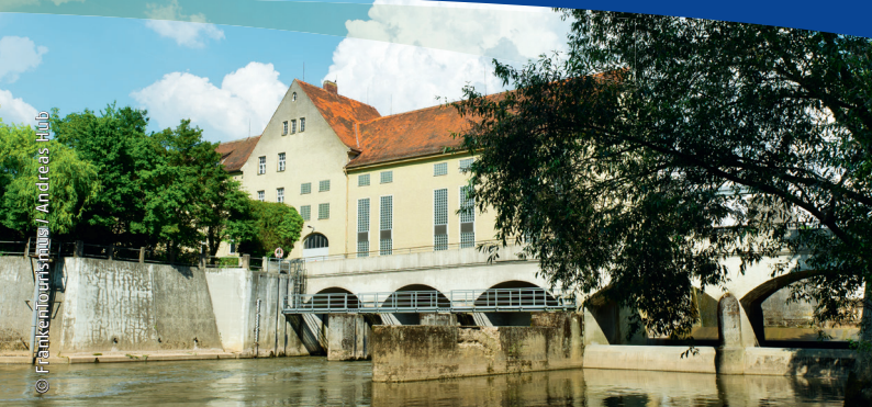
Wasserkraftwerk zwischen Strullendorf und Hirschaid
