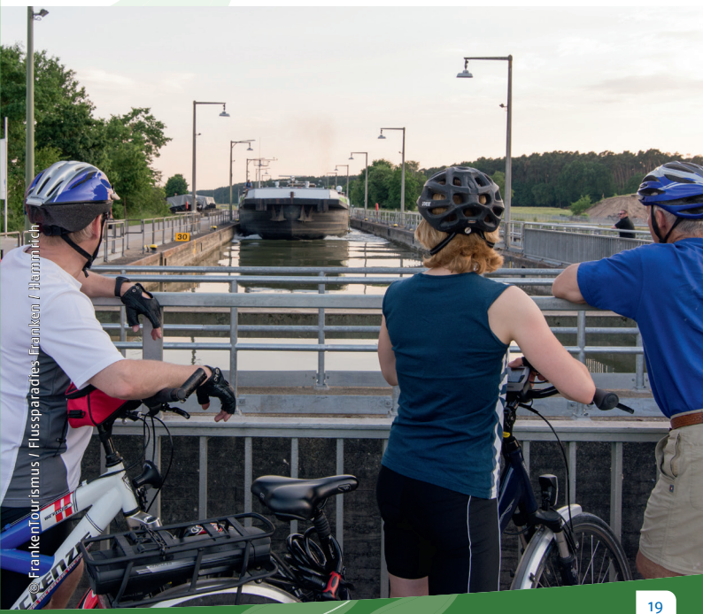
Schleuse Hausen am Main-Donau-Kanal
