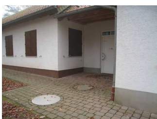
Weg vom Parkplatz zum Nebeneingang
