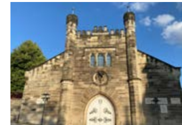
Studiobühne „Theater in der Reithalle“
