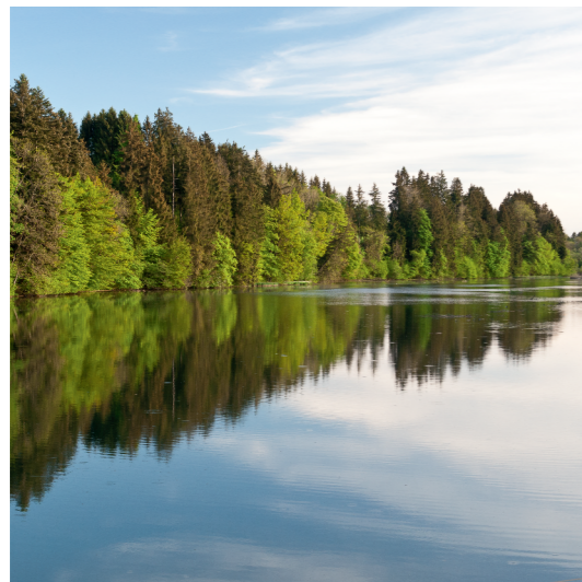
Seit 1925 wird das Wasser der Unteren Argen zum Gottrazhofer Stausee aufgestaut.
