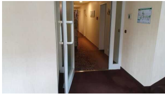
Nebeneingang zu Zimmer 24 und 25
