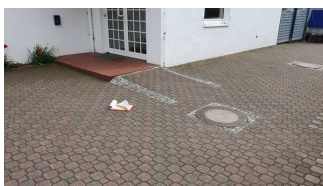
Nebeneingang zu Zimmer 24 und 25
