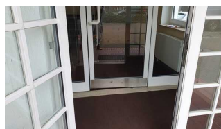
Nebeneingang zu Zimmer 24 und 25
