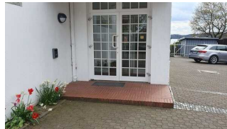
Nebeneingang zu Zimmer 24 und 25
