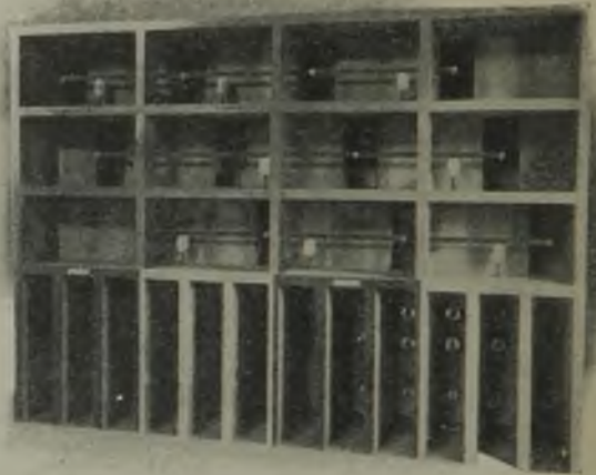
Abb. 15. Sammelschienenensystem, von vorn gesehen.
