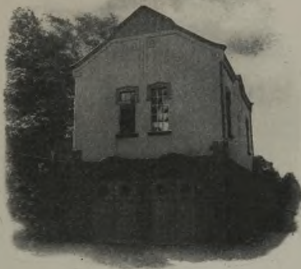
[Abb. 17. Ansicht eines Unterstationsgebäudes.]
