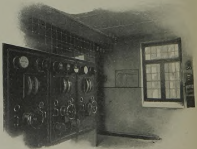
Abb. 16. Ansicht einer Schaltwagenanlage.
