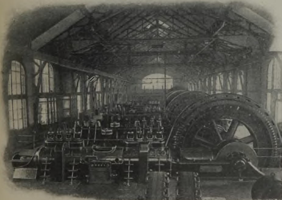
Abb. 4. Innenansicht der Zentrale Heinitz.
