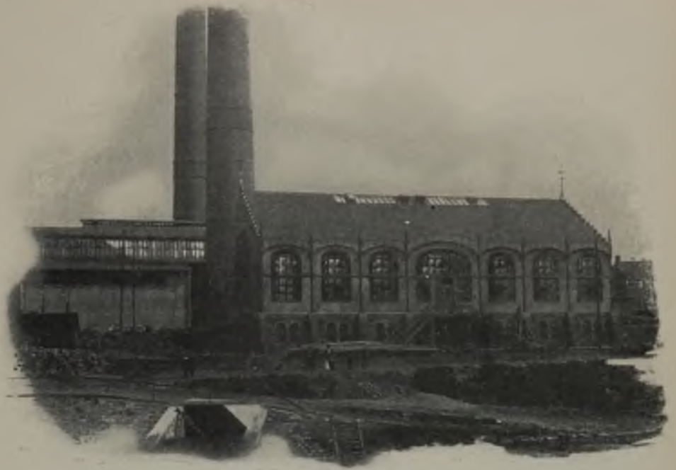
Abb. 9. Elektrische Zentrale Louisenthal nebst dahinter liegendem Kesselhaus.
