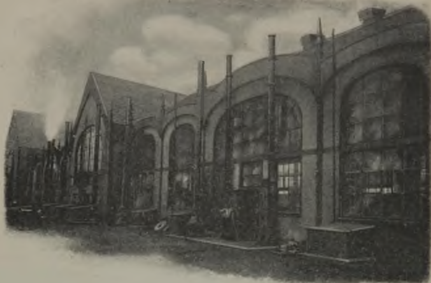
Abb. 3. Außenansicht der Zentrale Heinitz.
