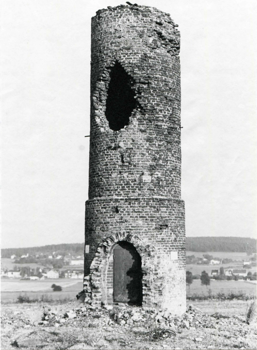
Abb.17: Die Überreste des ehemaligen Luft- bzw. Wetterschachtes der Grube Diepenlinchen. - Heute letzter Zeuge eines früheren Untertagebergbaus im Gebiet von Stolberg-Mausbach.
