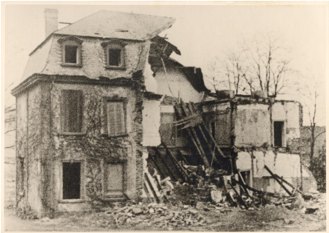
Am 11.12.1944 stark beschädigter Rosenhof in Lahnstein
