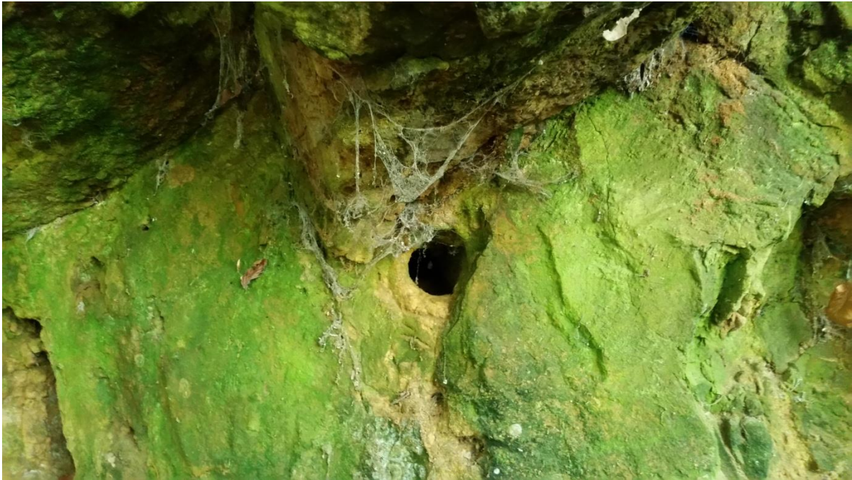
Abbildung 6: Bohrloch in der Steilwand unterhalb der Abraumhalde, Photo: Jens Mieckley, Juli 2016
