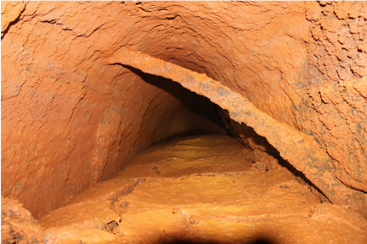
Abbildung 5: Haupt- und Entwässerungsstollen; Photo: Jens Mieckley 2018
