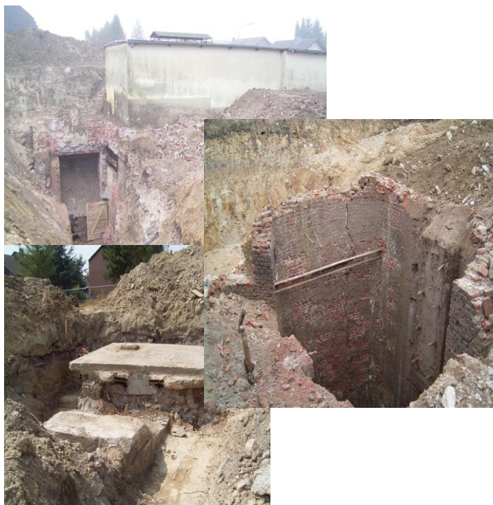
Abbildung 14: Sicherungsmaßnahmen Blume und Widmannschacht, Bildarchiv Jens Mieckley
